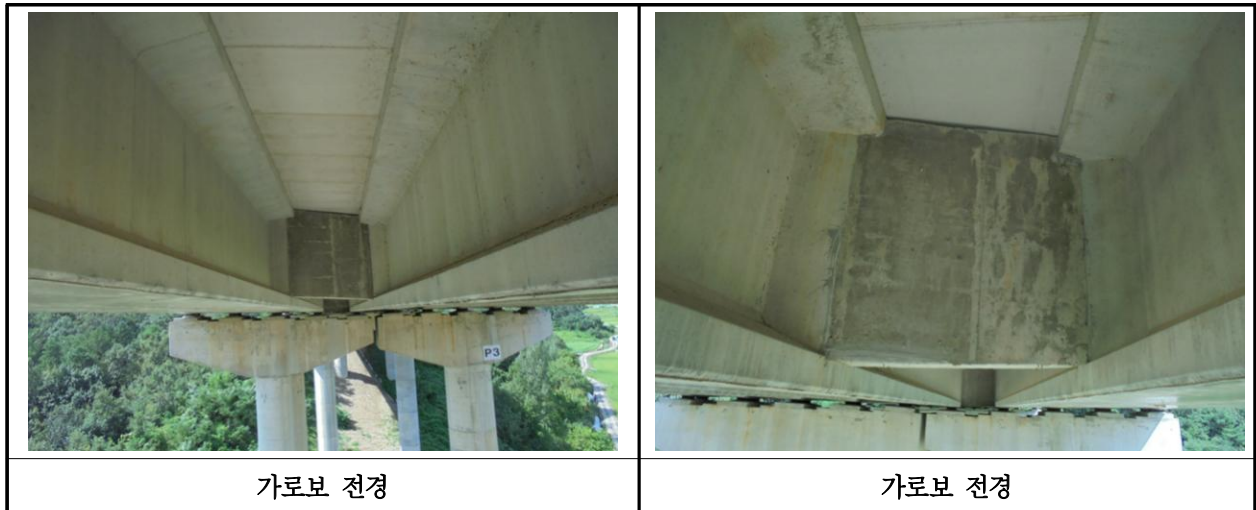
【사진 12.3.29】 가로보 전경
