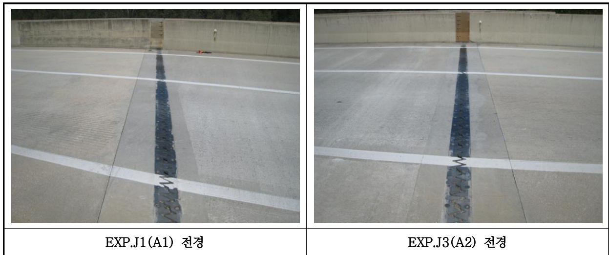
【사진 12.3.39】 신축이음장치 전경
