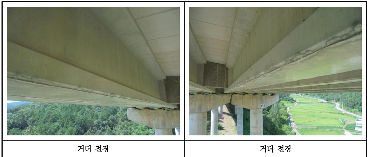
【사진 12.3.27】 거더 전경
