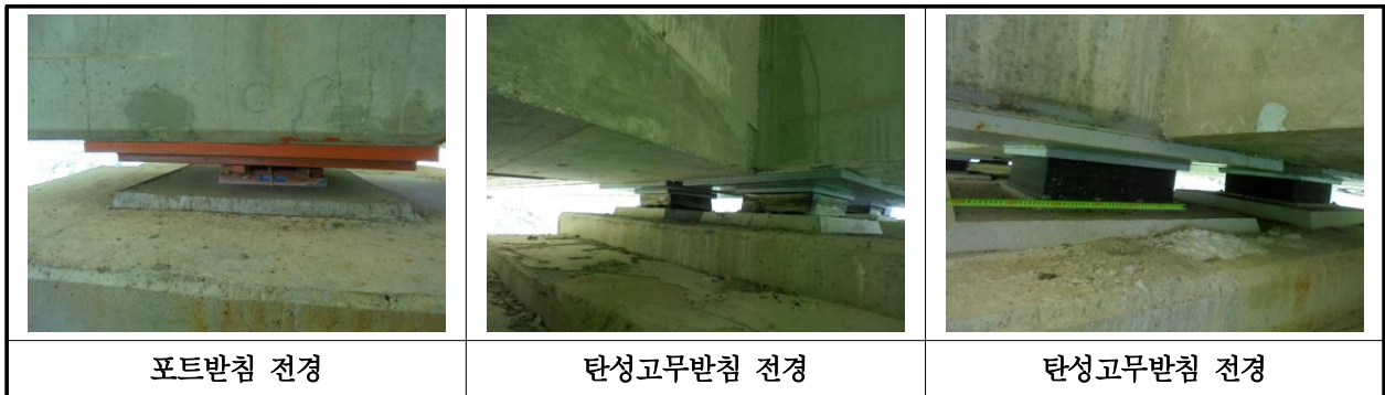
【사진 12.3.35】 교량반침 전경
