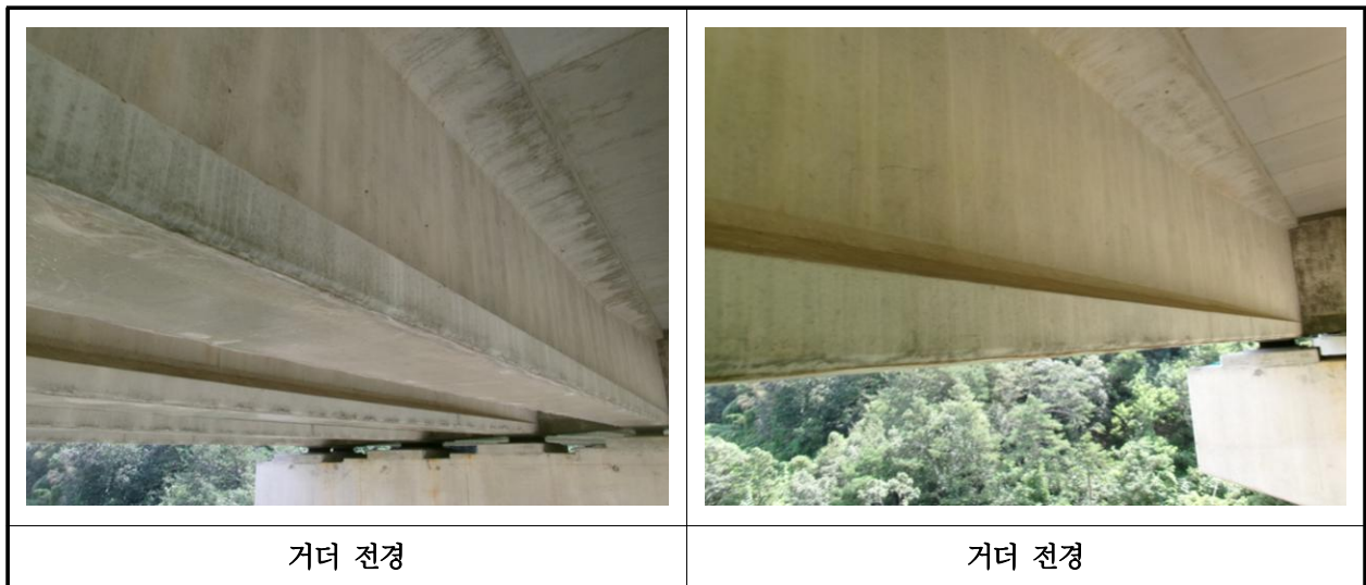
【사진 12.3.4】 거더 전경
