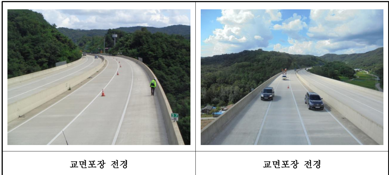
【사진 12.3.42】 교면포장 전경
