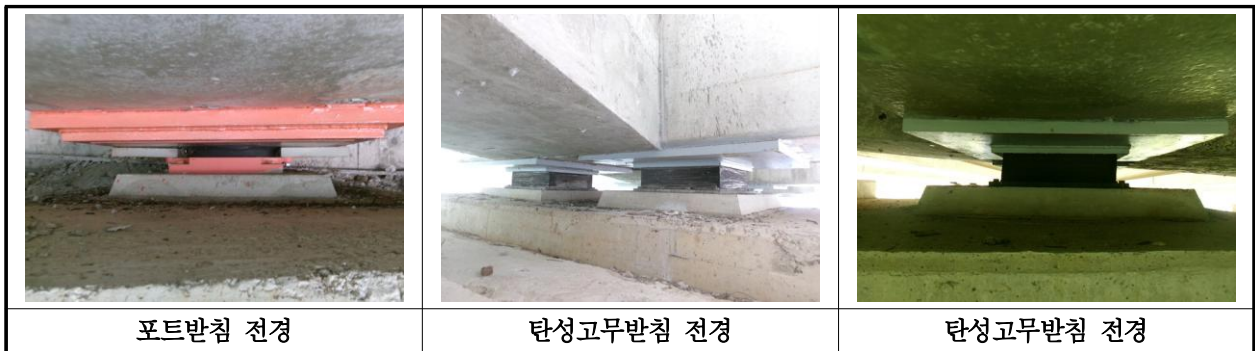
【사진 12.3.12】 교량반침 전경
