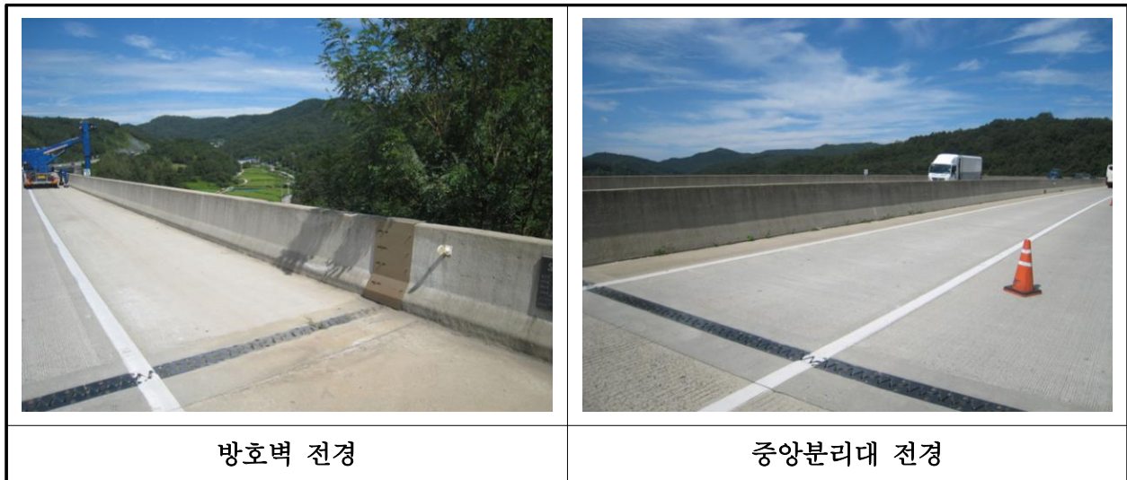
【사진 12.3.23】 방호벽 및 중앙분리대 전경
