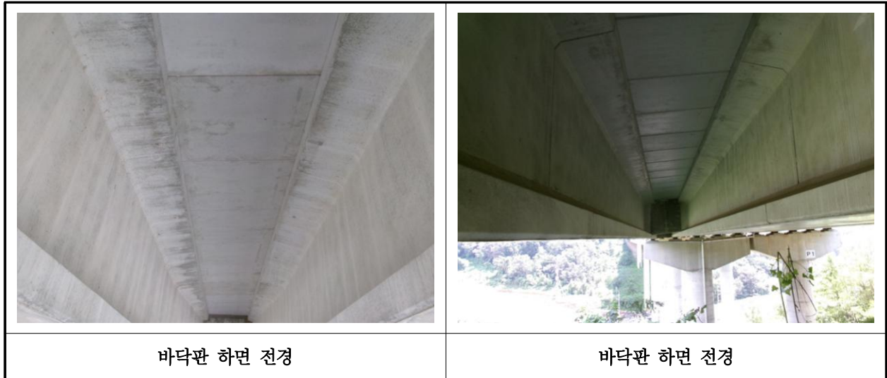
【사진 12.3.2】 바닥판하면 전경
