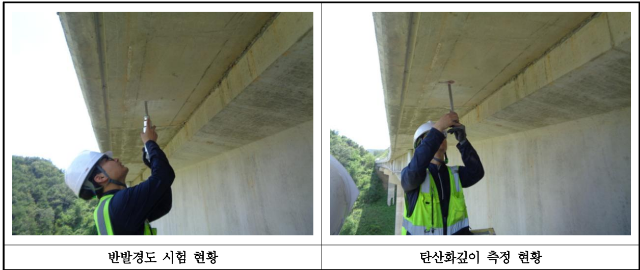
【사진 12.4.1】 콘크리트 내구성조사 현황
