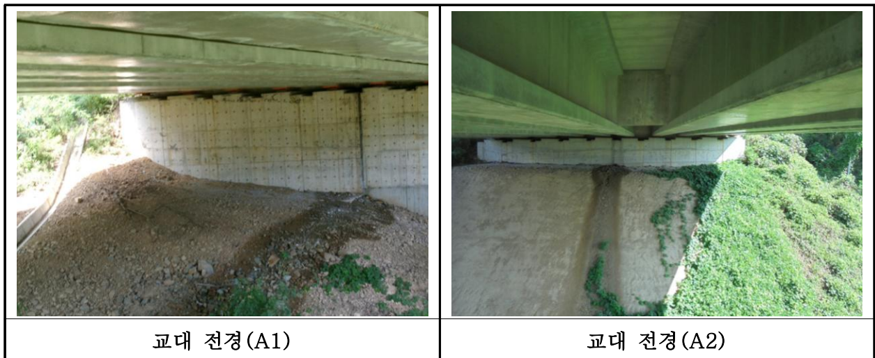
【사진 12.3.31】 교대 전경
