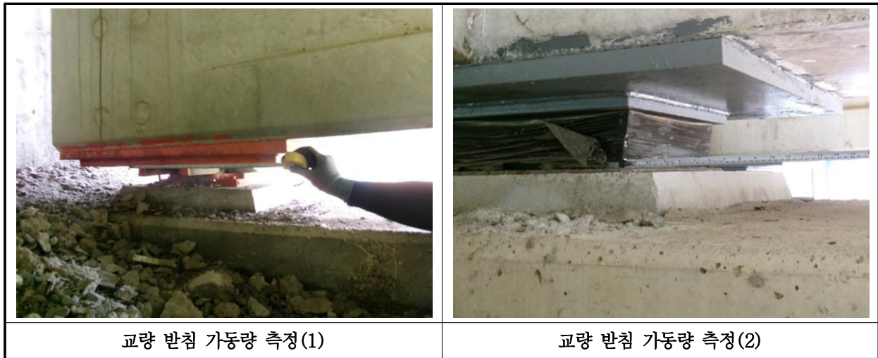
【사진 12.3.15】 교량받침 이동량 측정
