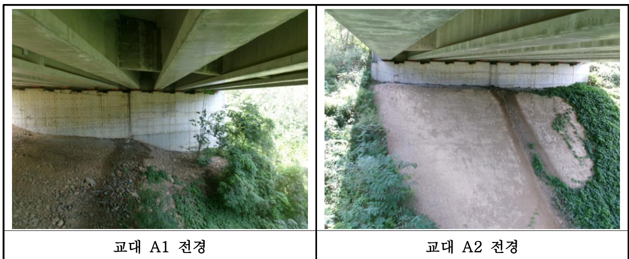
【사진 12.3.8】 교대 전경
