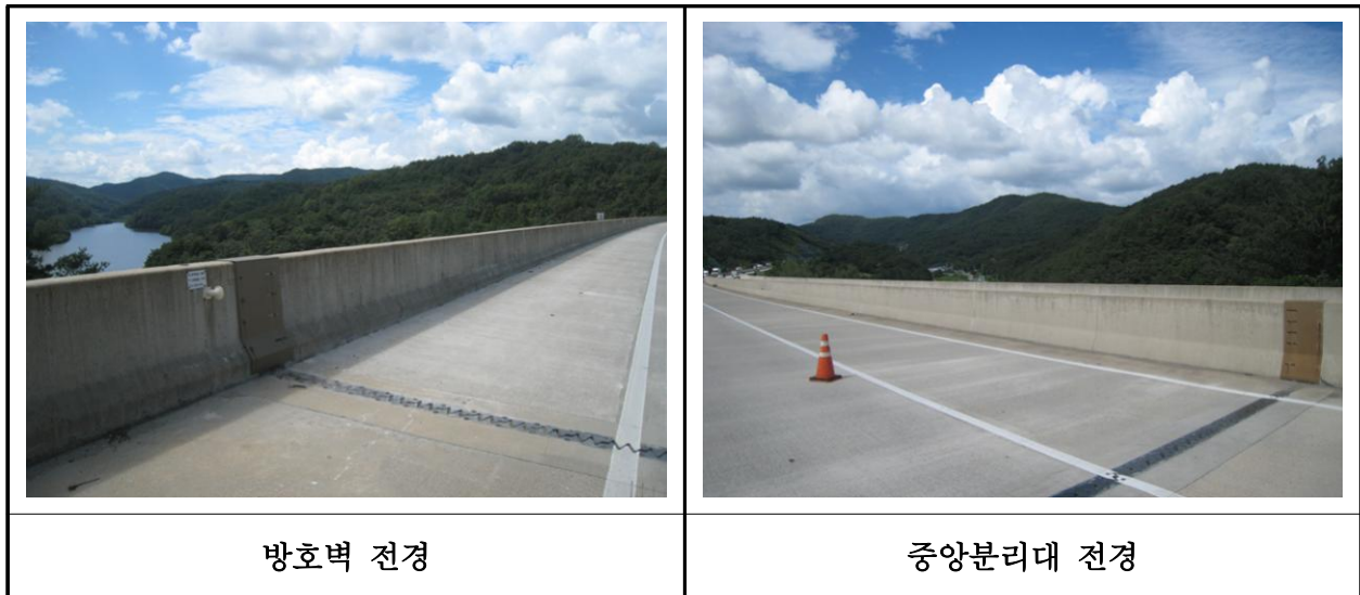
【사진 12.3.46】 방호벽 및 중앙분리대 전경
