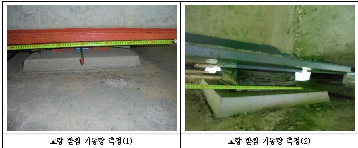
【사진 12.3.38】 교량받침 이동량 측정
