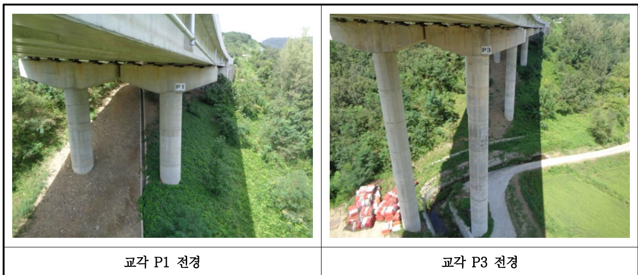
【사진 12.3.10】 교각 전경
