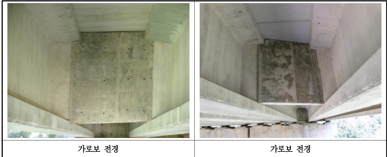
【사진 12.3.6】 가로보 전경
