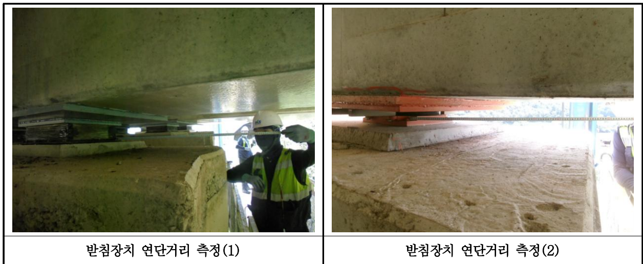
【사진 12.3.37】 교량받침장치 연단거리측정
