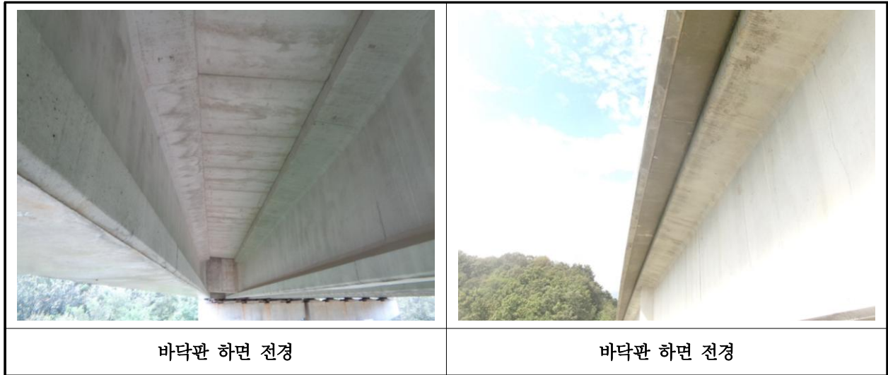
【사진 12.3.25】 바닥판하면 전경
